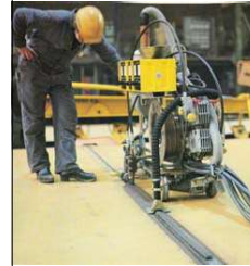
Kalın levhaların yatay pozisyonda küt alın kaynağı
