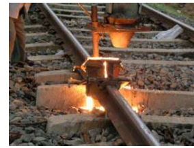
Termit kaynağı uygulaması: Ray kaynağı
