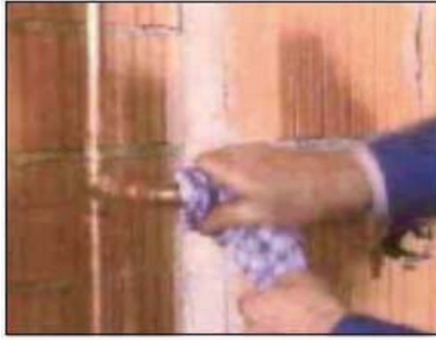
Resiml 38:Lehimleme işleminin sonrası lehim artıkları bir fırça ile temizlenir.
