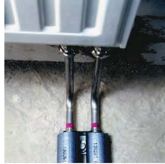
Resim 3. 1. 2: PE boruların radyatöre bağlantı şekilleri
