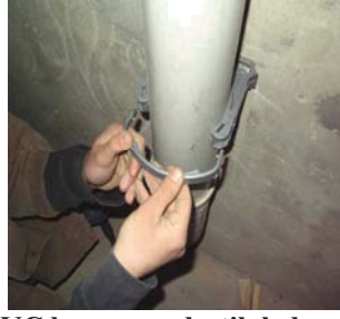
Resim 1.4.2.4: PVC borunun plastik kelepçe ile sabitlenmesi
