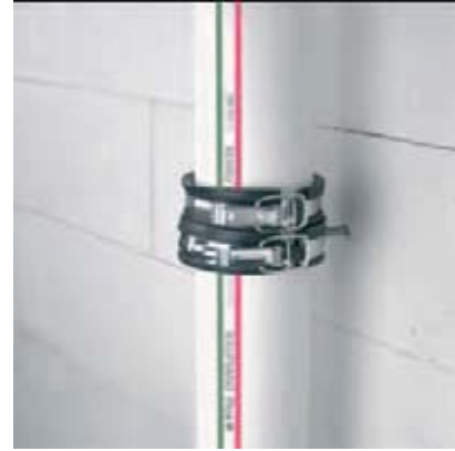
Resim 1.4.2.5: PVC borunun metal kelepçe ile sabitlenmesi
