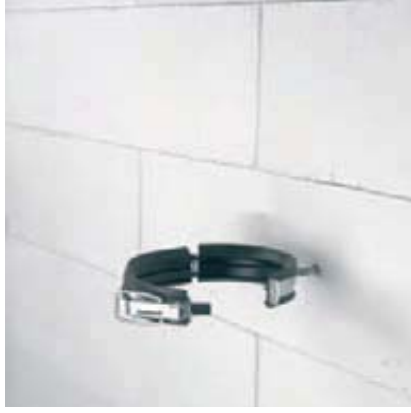
Resim 1.4.2.4: PVC borunun plastik kelepçe ile sabitlenmesi
