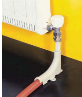
Resim 3. 1. 2: PE boruların radyatöre bağlantı şekilleri
