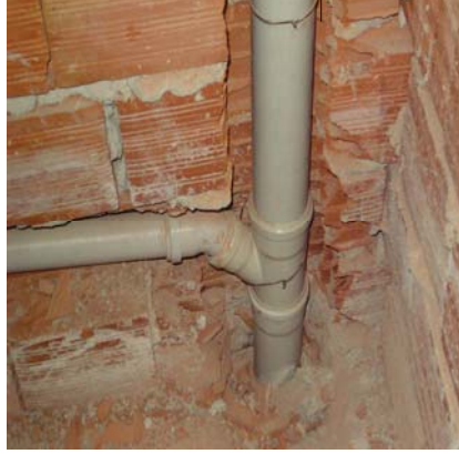
Resim 1.4.1: Yatay dikey boruların tespiti
