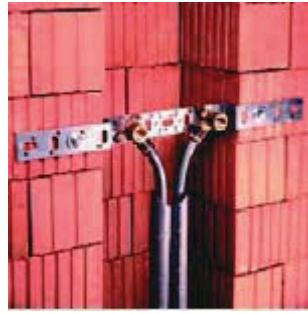
Resim 3. 2. 2: Tesisat uç noktalarının sabitlenmesi
