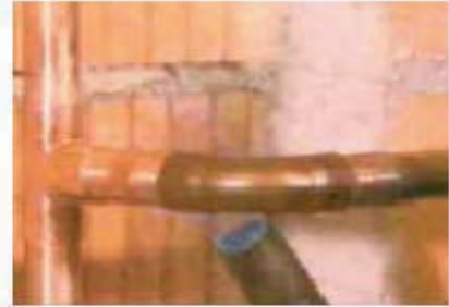
Resim2.8: Birleştirilecek parçaların oksi-gaz pürmüzü ile lehim sıcaklığına kadar ısıtılır.
