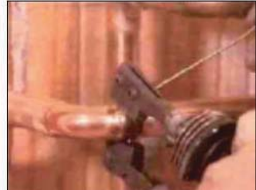
Resim 1.34: Lehim bölgesi elektrot çenelerin arasına alınarak lehimleme sıcaklığına getirilir. Ardından lehim aralığına lehim teli verilerek lehimlenir.
