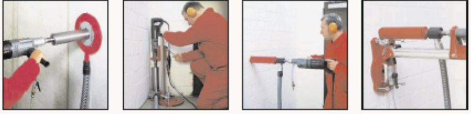
Resim1.15:Karot ile duvar ve döşeme delme uygulaması
