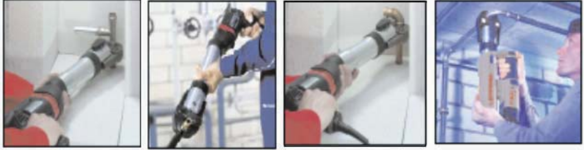
Resim 3.5: Tesisat projesine uygun döşenmiş boruların üzerine takılan o-ring contalı fittingslerin elektrikli pres makinesiyle değişik noktalarda preslenmesi uygulamalarıdır.
