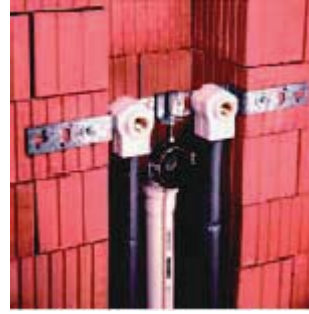
Resim 3. 2. 2: Tesisat uç noktalarının sabitlenmesi
