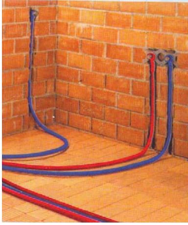
Resim 3. 2. 1: Kanal içerisinde PEX boru
