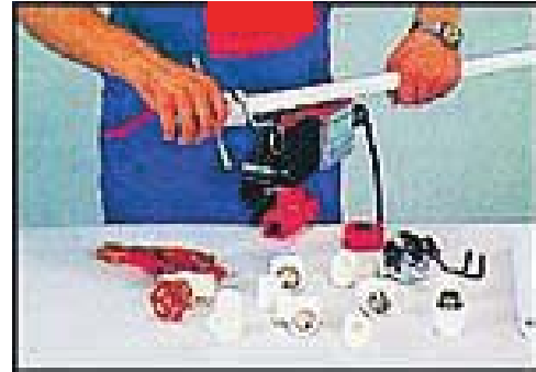
2. Folyolu boru ise alüminyum folyoyu soyma
