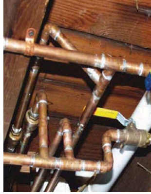
Resim1.12:Sıva üstü(yatay-düşey) uygulaması
