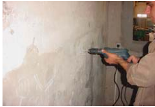
Resim 1.4.2.1: Matkap ile delik açma
