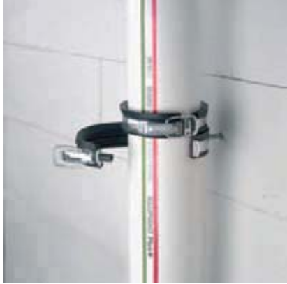
Resim 1.4.2.5: PVC borunun metal kelepçe ile sabitlenmesi
