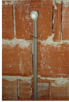
Resim 2.1.1: Kanal i inde PP boru
