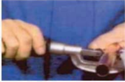
Resim2.3: Bakır boru tesisat projesine uygun ölçüde boru keski ile kesilir
