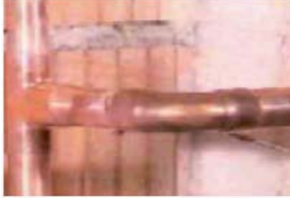
Resim2.9: Lehim sıcaklığına gelmiş parçalara yeterli miktarda lehim teli verilir.
