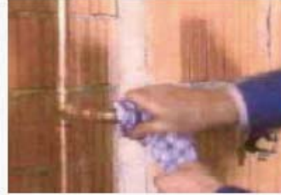
Resim2.10: Lehimleme işlemi sonrası dekapan artıkları temizlenir.
