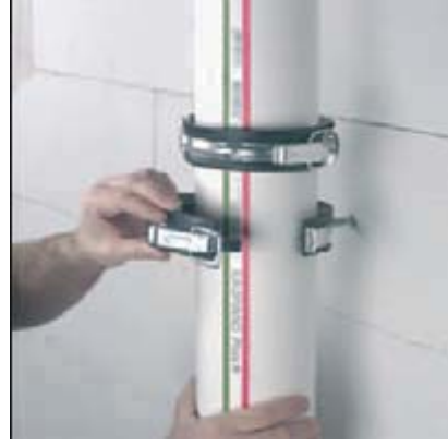
Resim 1.4.2.4: PVC borunun plastik kelepçe ile sabitlenmesi
