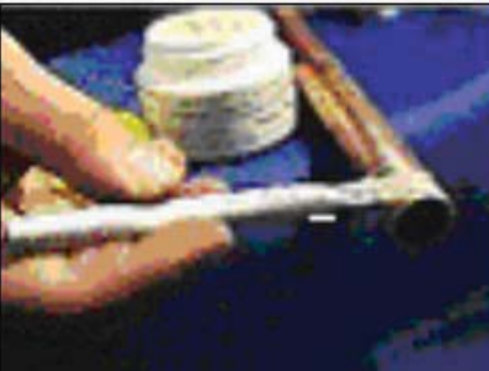
Resim 1.33: Borunun ucuna özel fırçayla dekapan sürülür.
