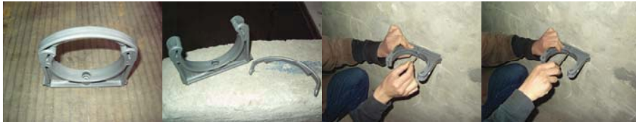
Resim 1.4.2.3: Plastik kelepçenin duvara sabitlenmesi
