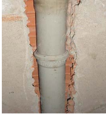
Resim 1.3.1: Kanal içerisine yerleştirilen boru
