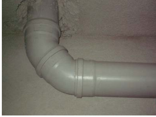
Resim 1.2: Kolon altında iki açık dirsek kullanımı
