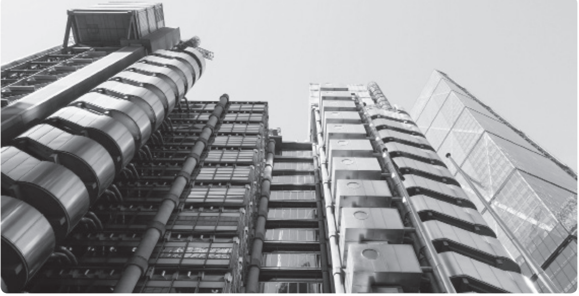
Görsel 1.6: Londra Lloyd's binası
