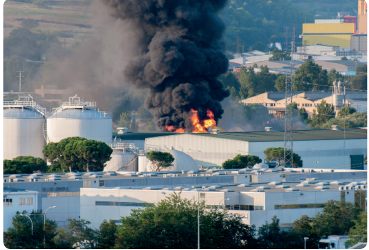
Görsel 2.6: Hasar gören iş yeri
